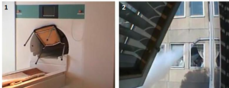
**QUENCH: 1.- Objeto obstruyendo el orificio del equipo de RMN; 2.- Salida del Helio por la chimenea tras provocar un Quench.**
